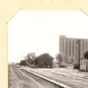
pohled přes sklad. kolej na skladiště, rampu a SILO Z172
